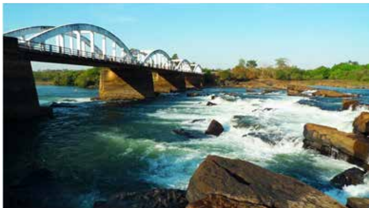
Rio Corubal – Ponte de Saltinho
