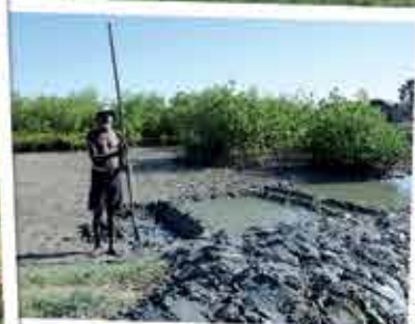
Manutenção dos diques
